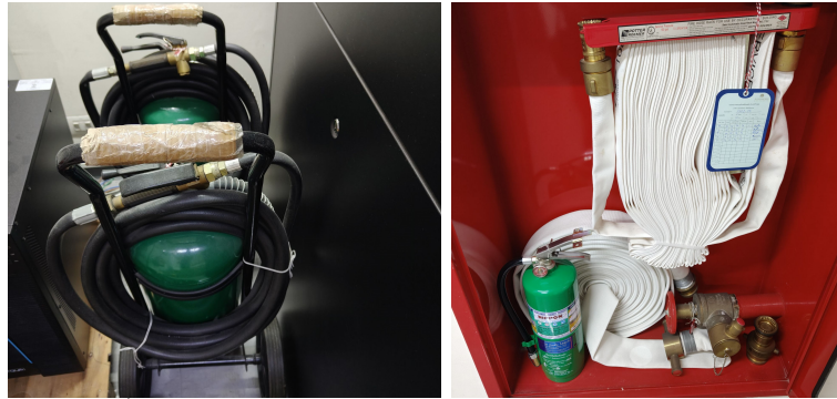
ภาพที่ 3-26 ถังเคมีดับเพลิงและป้ายคำแนะนำติดไว้ ตรวจสอบพร้อมใช้งาน
