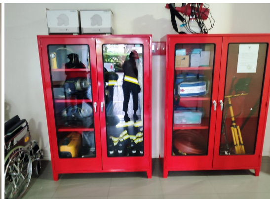
ภาพที่ 3-19 ตู้เก็บสายฉีดน้ำดับเพลิงและอุปกรณ์ มีสภาพสมบูรณ์พร้อมใช้งาน
