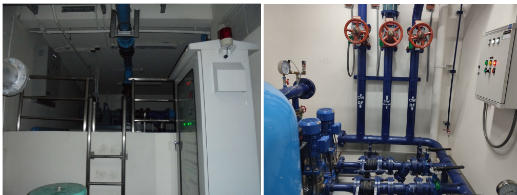
ภาพที่ 3-10 ห้องเครื่องประปา และถังสำรองน้ำใช้ ระบบท่อต่างๆ ไม่มีรั่วซึม
