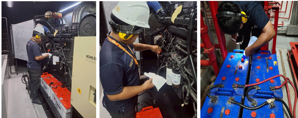
ภาพที่ 3-15 ห้องเครื่องระบบไฟฟ้าฉุกเฉิน และการตรวจสอบระบบไฟฟ้าฉุกเฉิน
