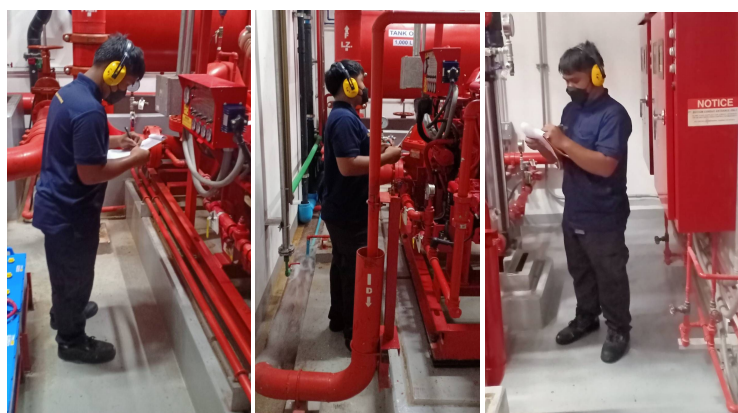
ภาพที่ 3-17 ห้องเครื่องสูบน้ำดับเพลิง และการตรวจสอบระบบFire Pump
