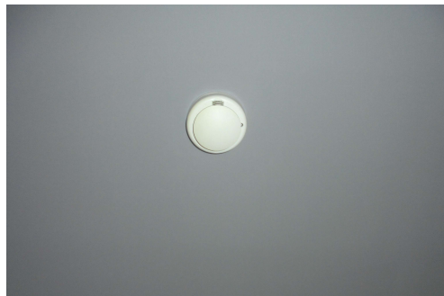
ภาพที่ 3-23 เครื่องตรวจจับความร้อน
