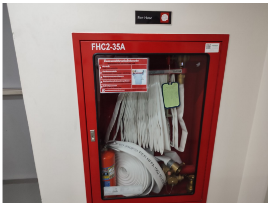
ภาพที่ 3-19 ตู้เก็บสายฉีดน้ำดับเพลิงและอุปกรณ์ มีสภาพสมบูรณ์พร้อมใช้งาน
